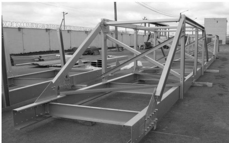
Рис. 1. Металево оцинкована ферма
