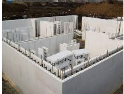
Рис. 3. Будинки з незнімною опалубкою
