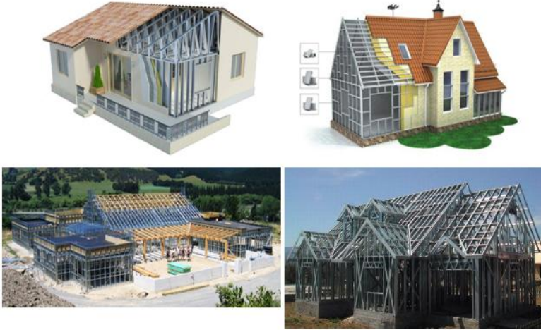
Рис.1. Каркасні малоповерхові будівлі із ЛСТК
