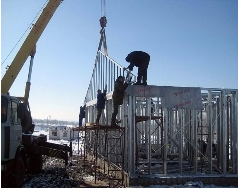
Рис.2. Монтаж крокв'яної конструкції із ЛСТК
