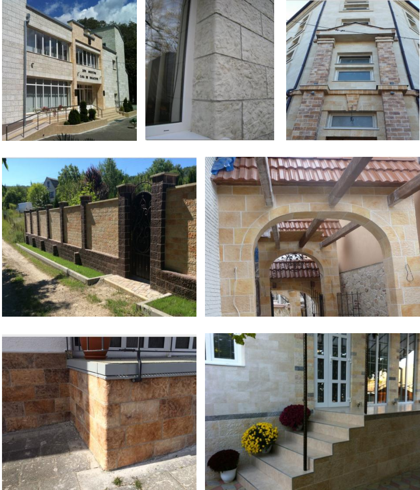
Рис. 1. Використання гнучкого каменю для зовнішнього облицювання
