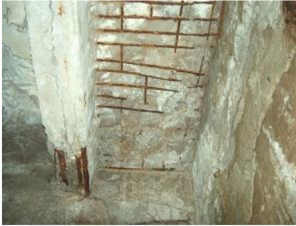
Рис.1. Корозія залізобетону
