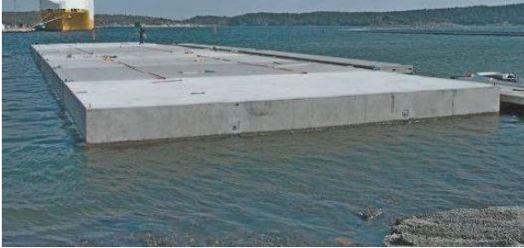
Рис. 3. Залізобетонні понтони, з'єднані між собою
