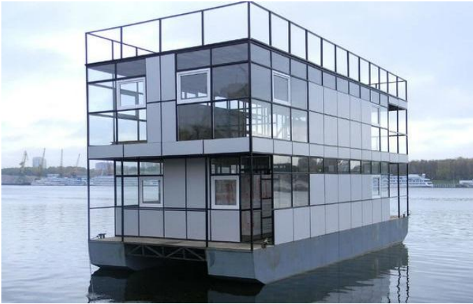
Рис. 6. Будівля на металевому понтоні
