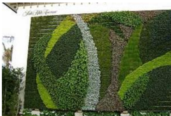
Рис. 1. Зелена стіна Worth Avenue
