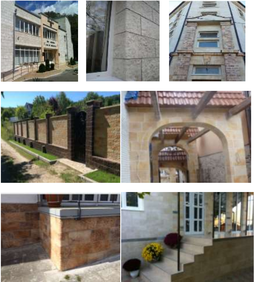
Рис. 1. Використання гнучкого каменю для зовнішнього облицювання
