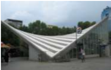
Рис. 3. Залізнична станція у Варшаві (Польща)
