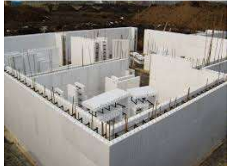
Рис. 3. Будинки з незнімною опалубкою
