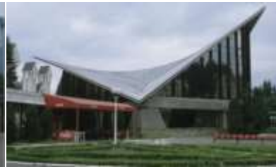
Рис. 4. Залізнична станція у Румунії
