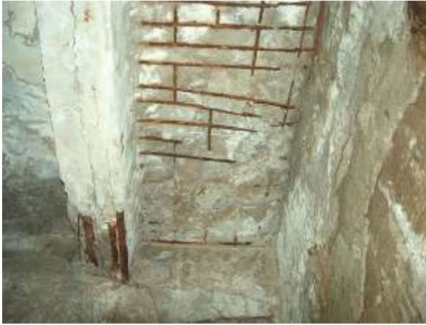
Рис.1. Корозія залізобетону
