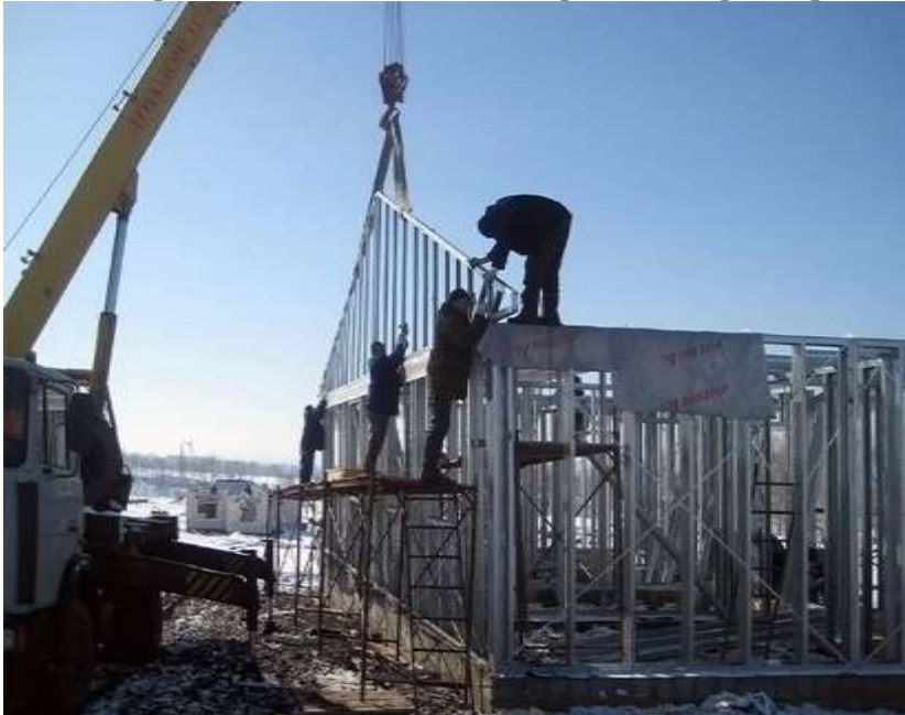
Рис.2. Монтаж кров'яної конструкції із ЛСТК
