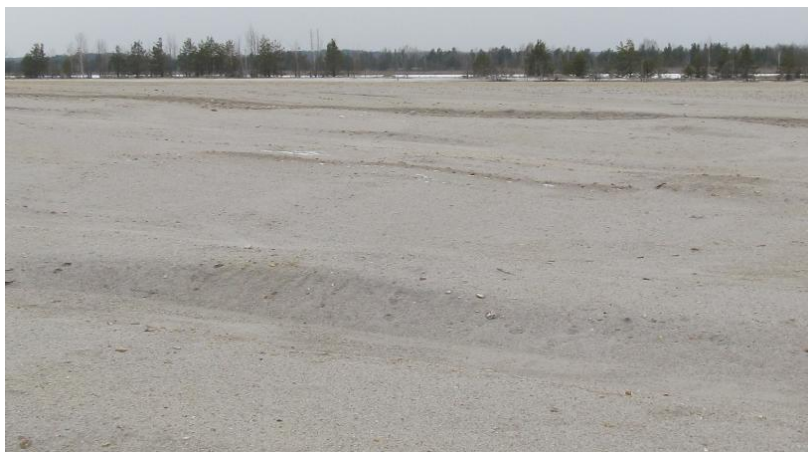
Рис.4. Пригнічення процесів самовідновлення ландшафтів на хвостосховищі зернистих шламів (білих кварцових пісків) внаслідок зневоднення в умовах дренажу та вкрай низького вмісту поживних речовин у них.
