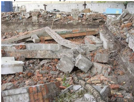
Рис. 1. Будівельні відходи, отримані в результаті демонтажу будівель і споруд.
