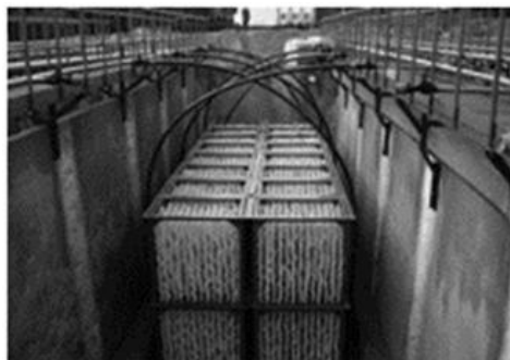
Рисунок 1 – Кассеты с волокнисто-пористым носителем биомассы производства ООО «Гефлис» (РБ)
