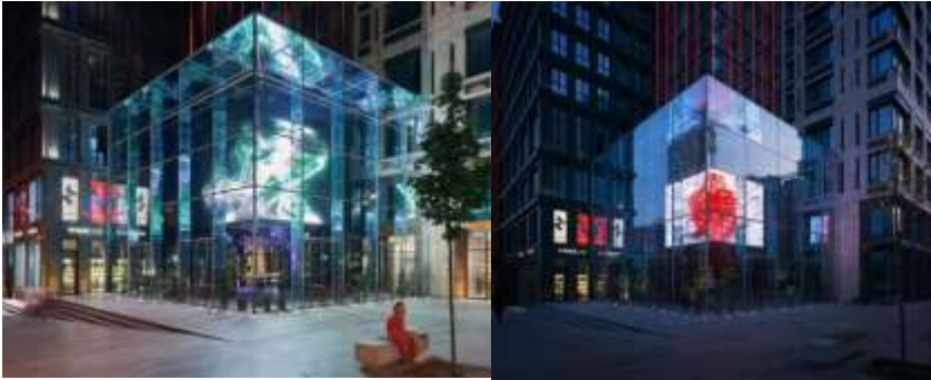
Рисунок 8. Приклади використання скла як LED екрану від компанії Building Energy Alliance.
