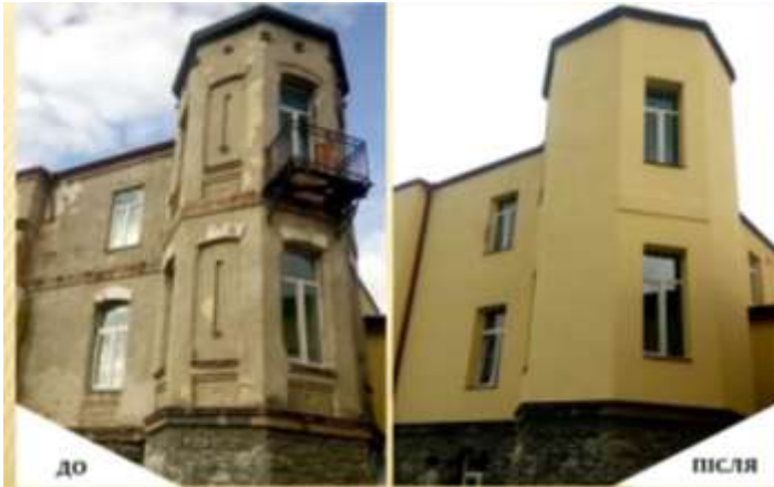
Рисунок 7 – утеплення фасаду історичної будівлі у селі Созань Львівської області.
