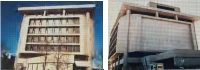
Рисунок 1 – Перша енергоефективна будівля, штат Нью-Хемпшир, США (1972)
