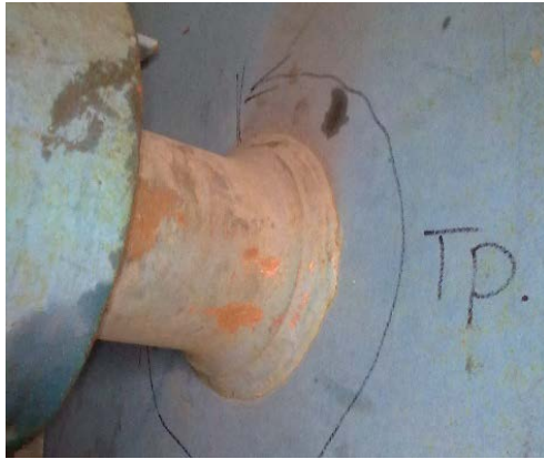
Рис. 19. Ділянка стінки лебідки, яка потенційно схильна до утворення в ній утомних тріщин
