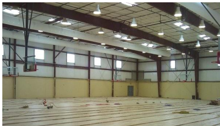
Загальний вид сталевго каркасу виробничої будівлі.
