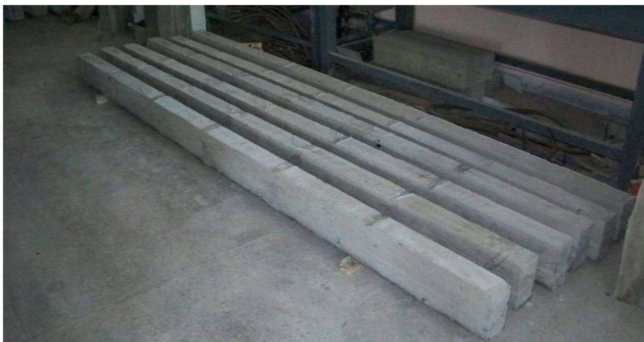
Рисунок 2.13 – Балки першої серії після розпалубки
