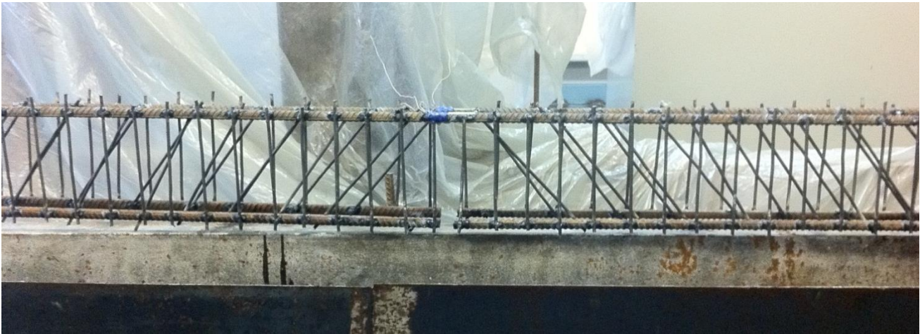
Рисунок 2.11 – Вигляд каркасу із влаштованими тензорезисторами
