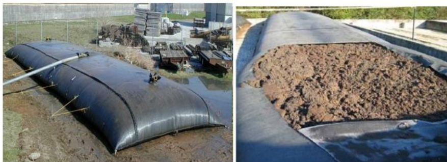
Рисунок 3.2 – Зневоднення сапропелю за допомогою технології Geotube: а) заповнення резервуару сапропелем; б) результат процесу зневоднення.
