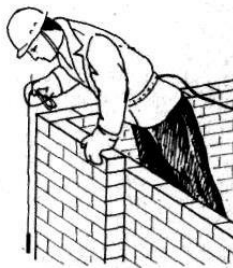
Рисунок 3.50. Безпечні прийоми кладки: а – огороження отворів; б – робота із запобіжним поясом
