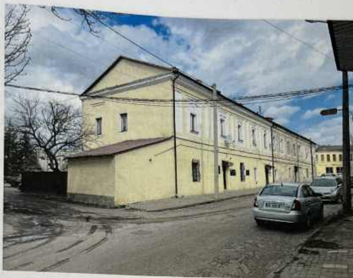
Стан фасадів будівлі у 2024 році
