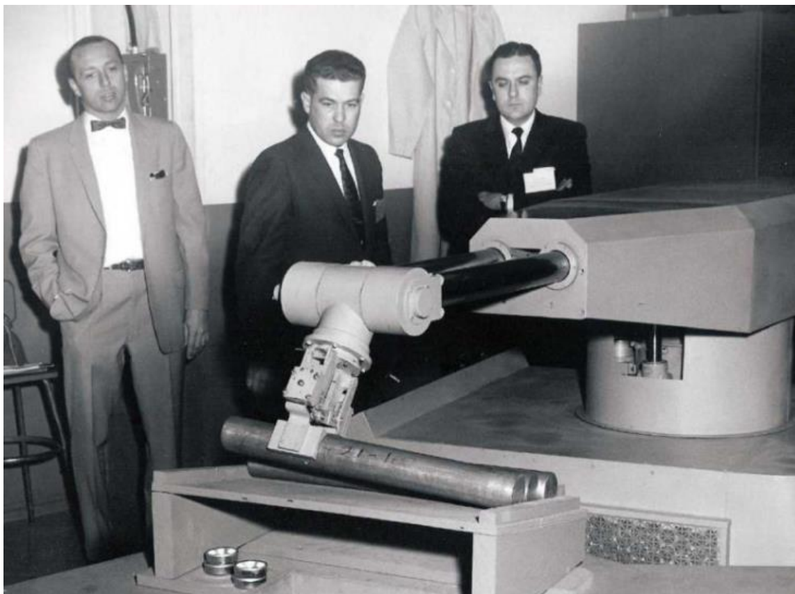
Рисунок 1.1 – Перший у світі промисловий робот Unimate [2]
